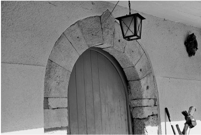
Abb. 4: Soazza GR. Praktisch unverändert erhaltener Torbogen (Bogen A). Die Oberfläche wurde feinsäuberlich mit dem Meissel bearbeitet.
