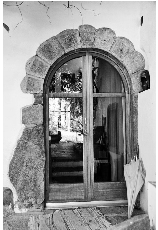
Abb. 10: Soazza GR, Bogen C. Der heutige Zustand entspricht nicht mehr demjenigen, den Simonett 1964 beschrieb. Der Bogen besitzt einen schwer deutbaren Schlussstein. Die restlichen Elemente haben einen fein behauenen Spiegel und glatte Ränder.
