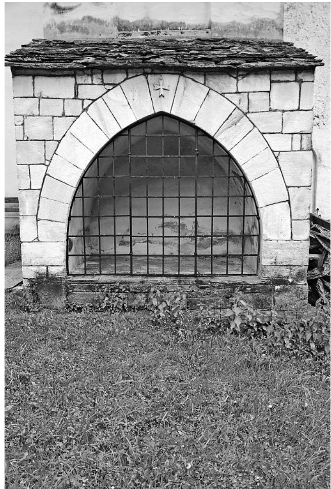
Abb. 2: Mesocco GR, Sta. Maria del Castello. Am Kirchenturm angebaut steht diese Nische mit Spitzbogen. Im Schlussstein befindet sich ein Basrelief mit Malteserkreuz.
